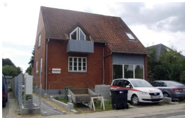
Byhus, hvor en håndværksmester med behov for plads har erstattet forhaven med parkerede biler, en trailer, oplagsplads og ufærdige mure, der passer dårligt ind i gadebillede.
