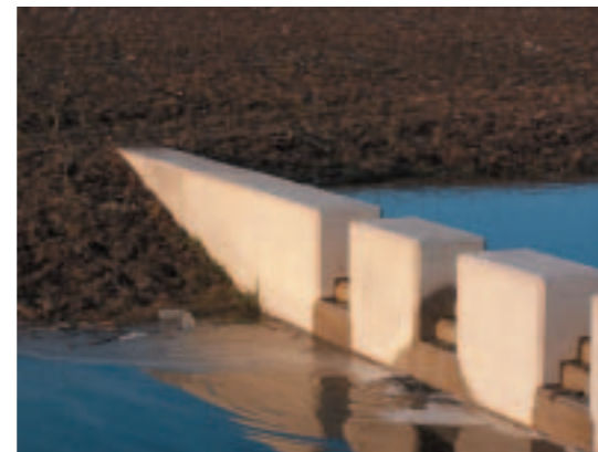
Overfaldsbygværk i beton og stål
