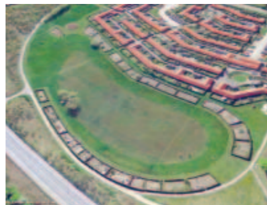
Eksempel på regnvandsreservoir
